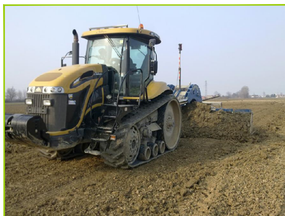
LIVELLAMENTO DEL TERRENO CON AUSILIO DI MEZZI MECCANICI
