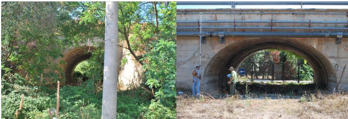
Figura 4: Tombini stradali di attraversamento infrastrutture presenti nella lama castello
