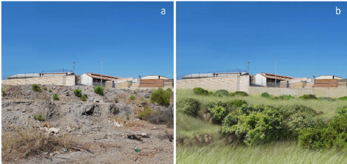
Figura 12: Stato dei luoghi nell'area di pendio sinistro della lama, prima (a) e dopo gli interventi di idrosemina e impianto di arbusti (b).
