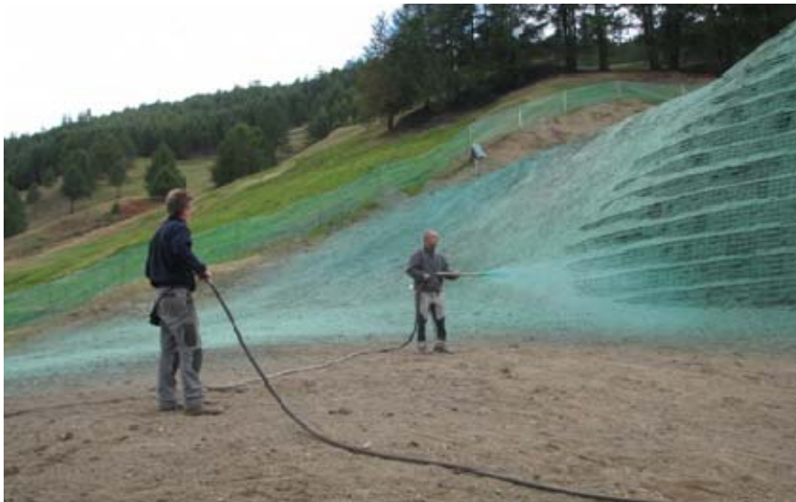
Figura 9: Esempio di intervento di idrosemina in spessore.
