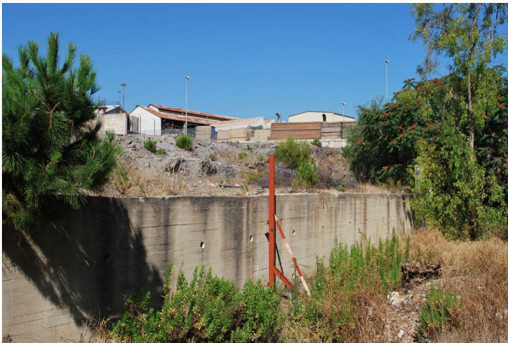
Figura 16: Muro di contenimento in calcestruzzo di separazione tra il Lotto II e la pineta posta più a valle.
