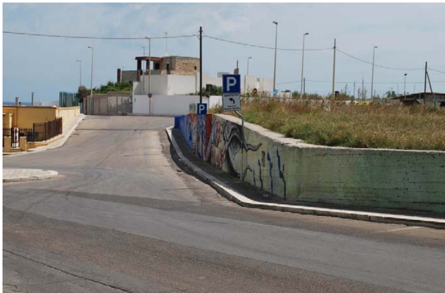
Figura 19: vista da lato est del muro di contenimento presente nell'area cantiere.
