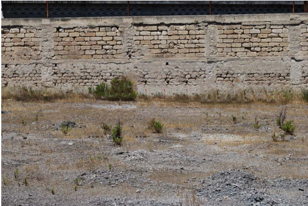
Figura 28: Muro di confine tra l'area di intervento e l'area delle ex AFP
