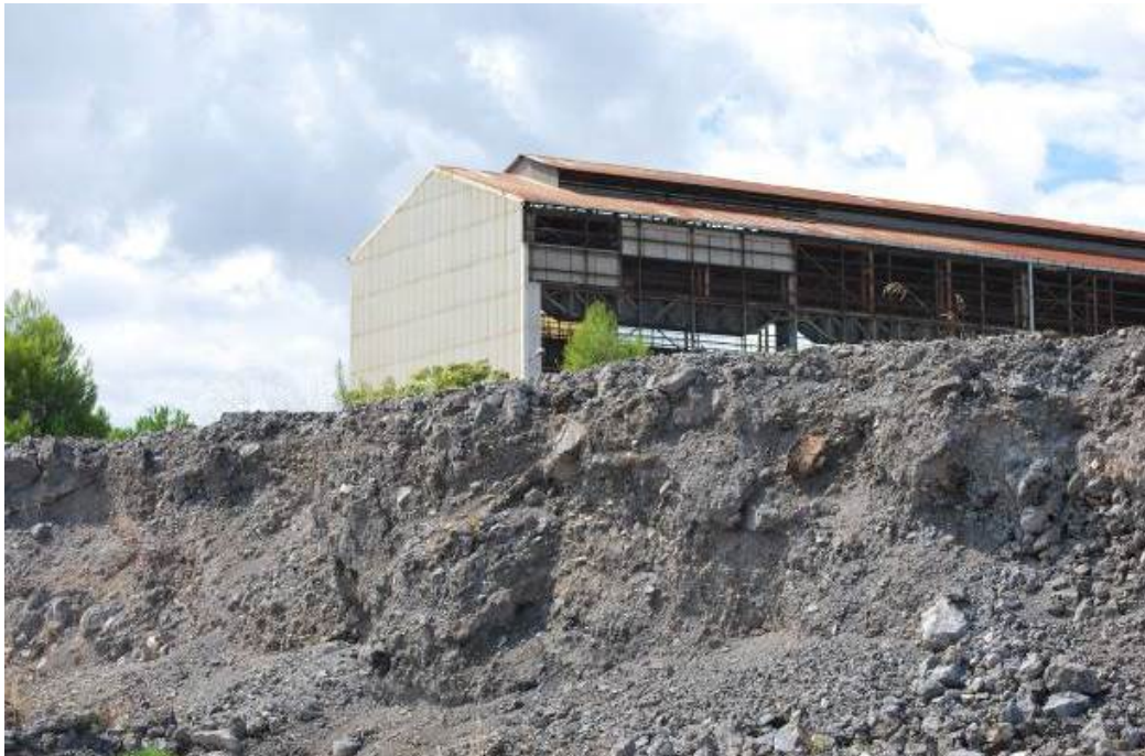
Figura 12: Vista del terrapieno di materiale abbancato.
