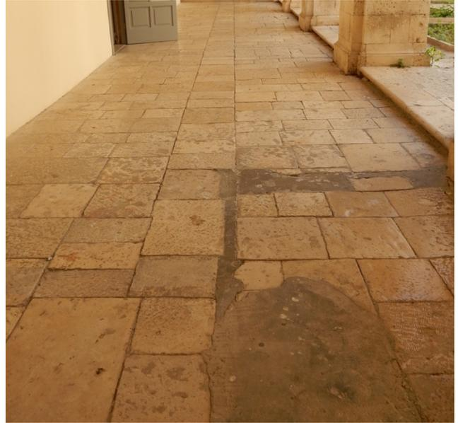
Figg. 24 e 25: Inseriti incoerenti nella pavimentazione in chianche del portico.
