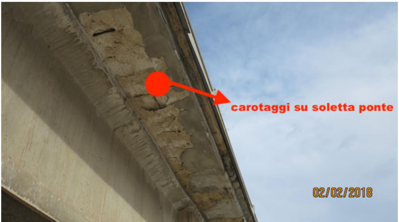
Foto con indicazione dei punti di prova sulla soletta del ponte. Il carotaggio deve essere
