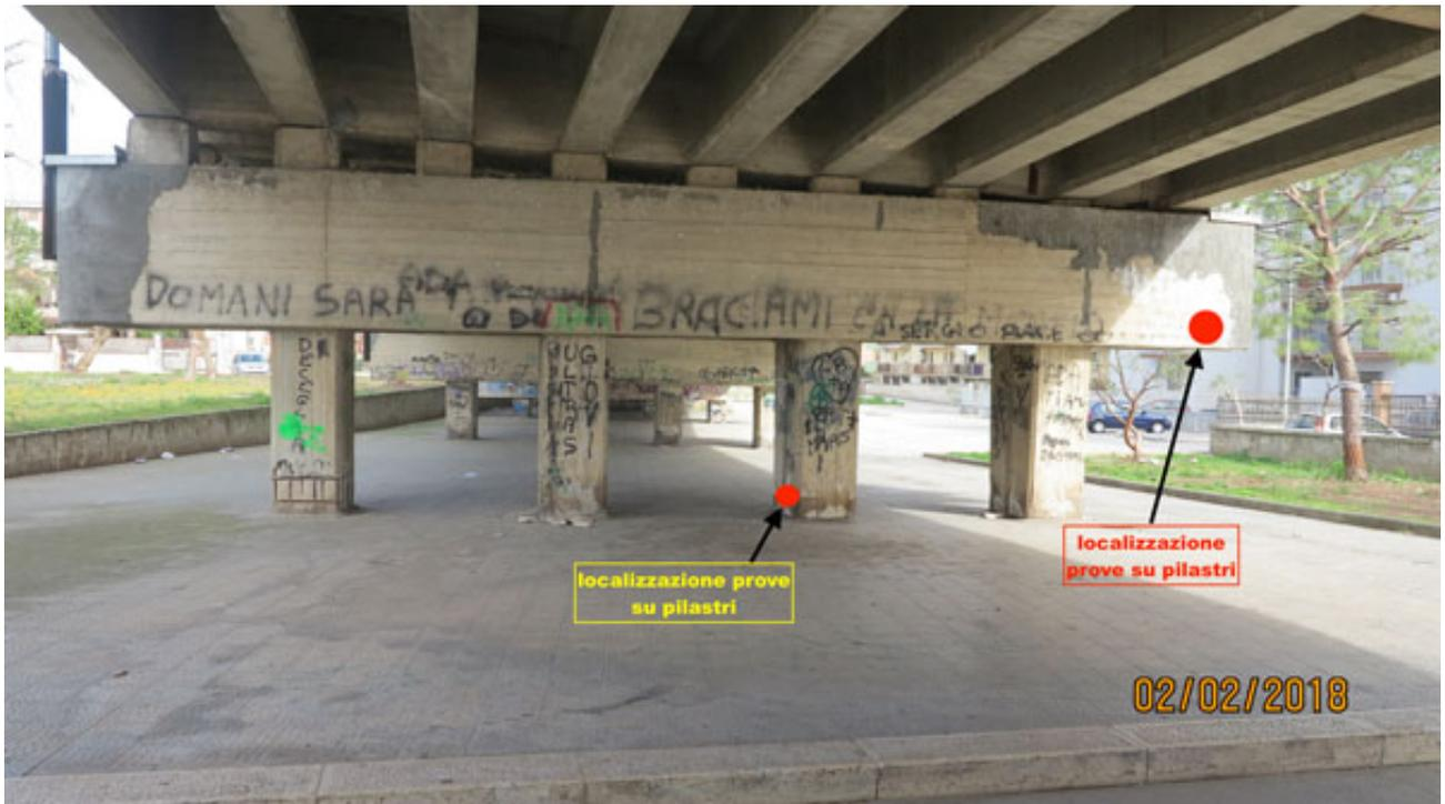
Foto con indicazione dei punti di prova su travi e pilastri.
