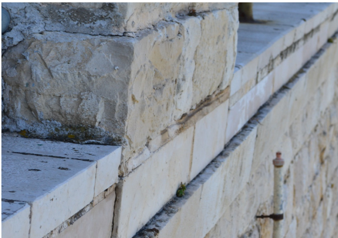
DEGRADO | particolare della soletta aggettante in c.a. e del basamento dei parapetti in pietra
