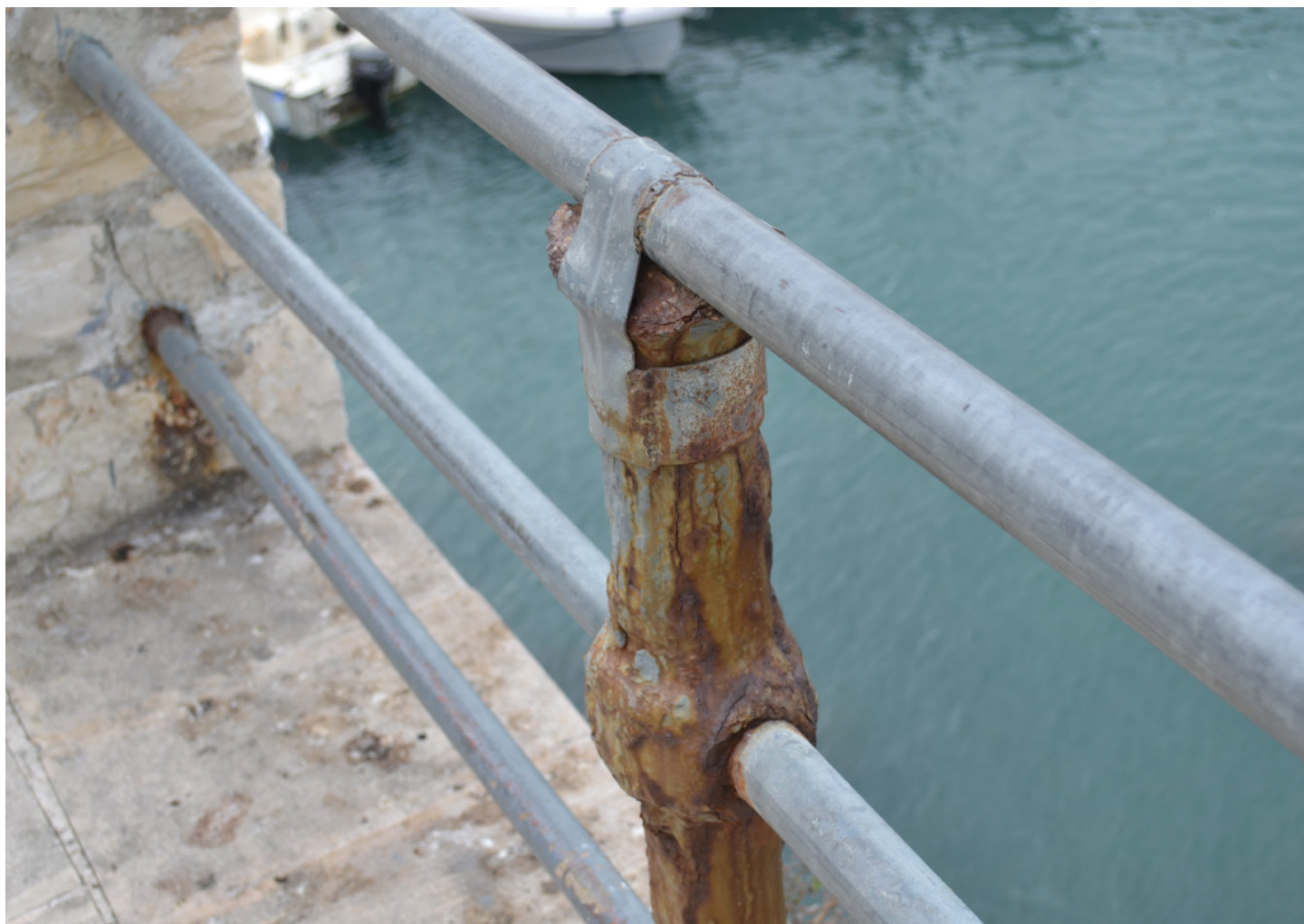
DEGRADO | particolare di elementi mancanti di una balaustra in ferro
