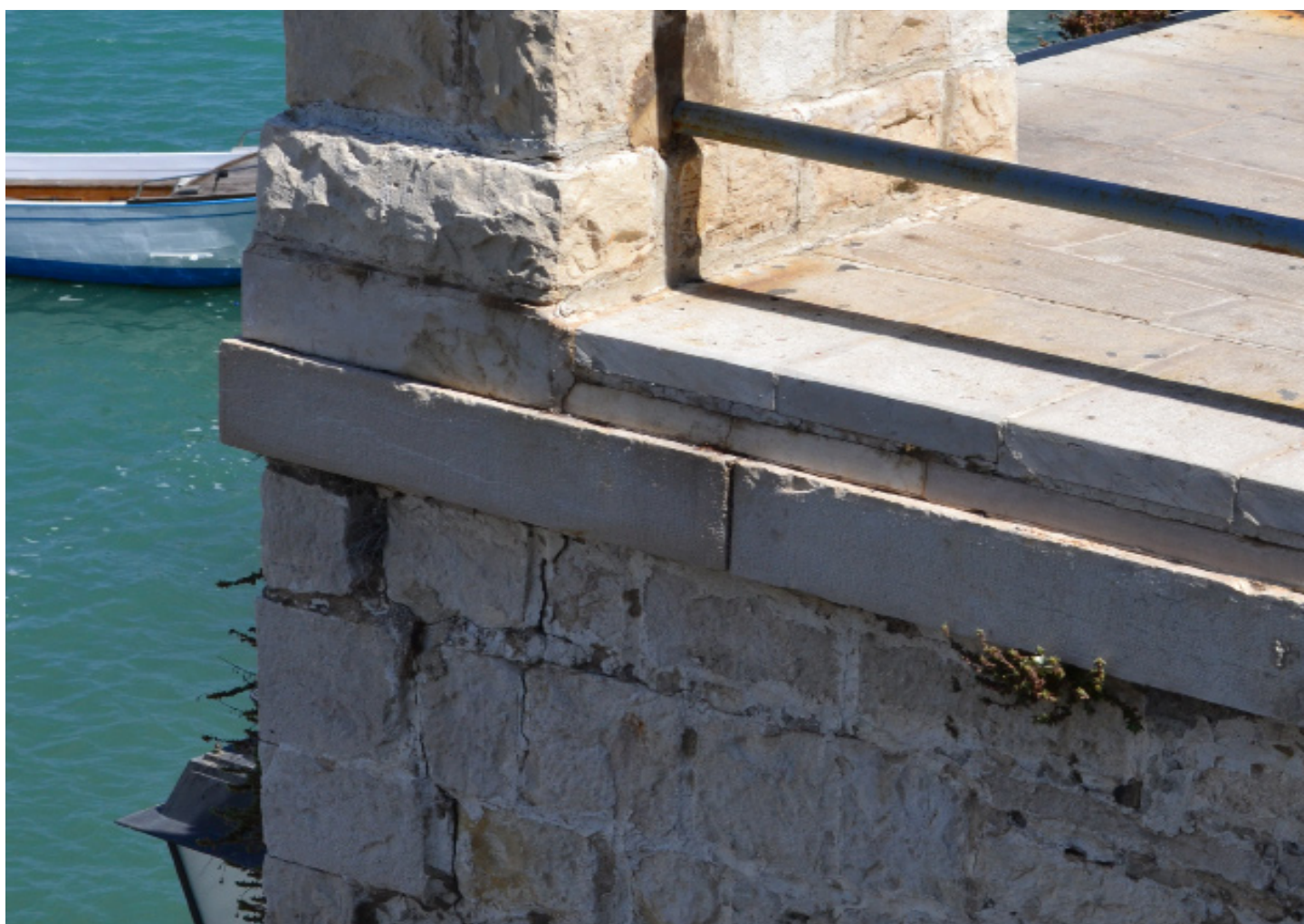
DEGRADO | particolare dell' attacco tra il muraglione e il parapetto in pietra
