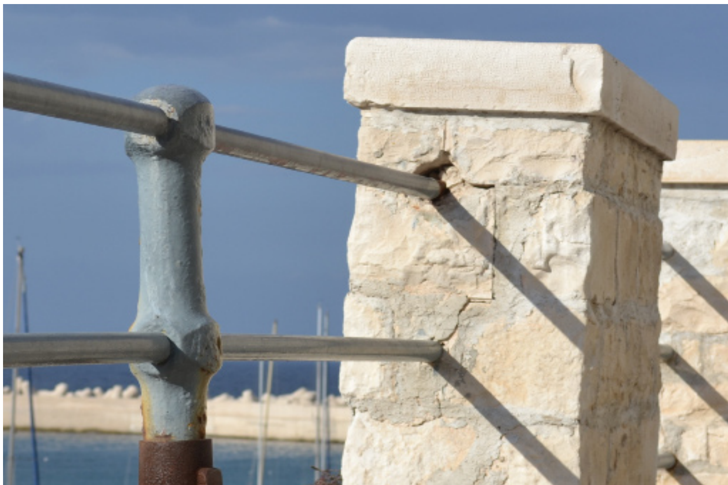
DEGRADO | particolare della giunzione tra il parapetto in pietra e la balaustra
