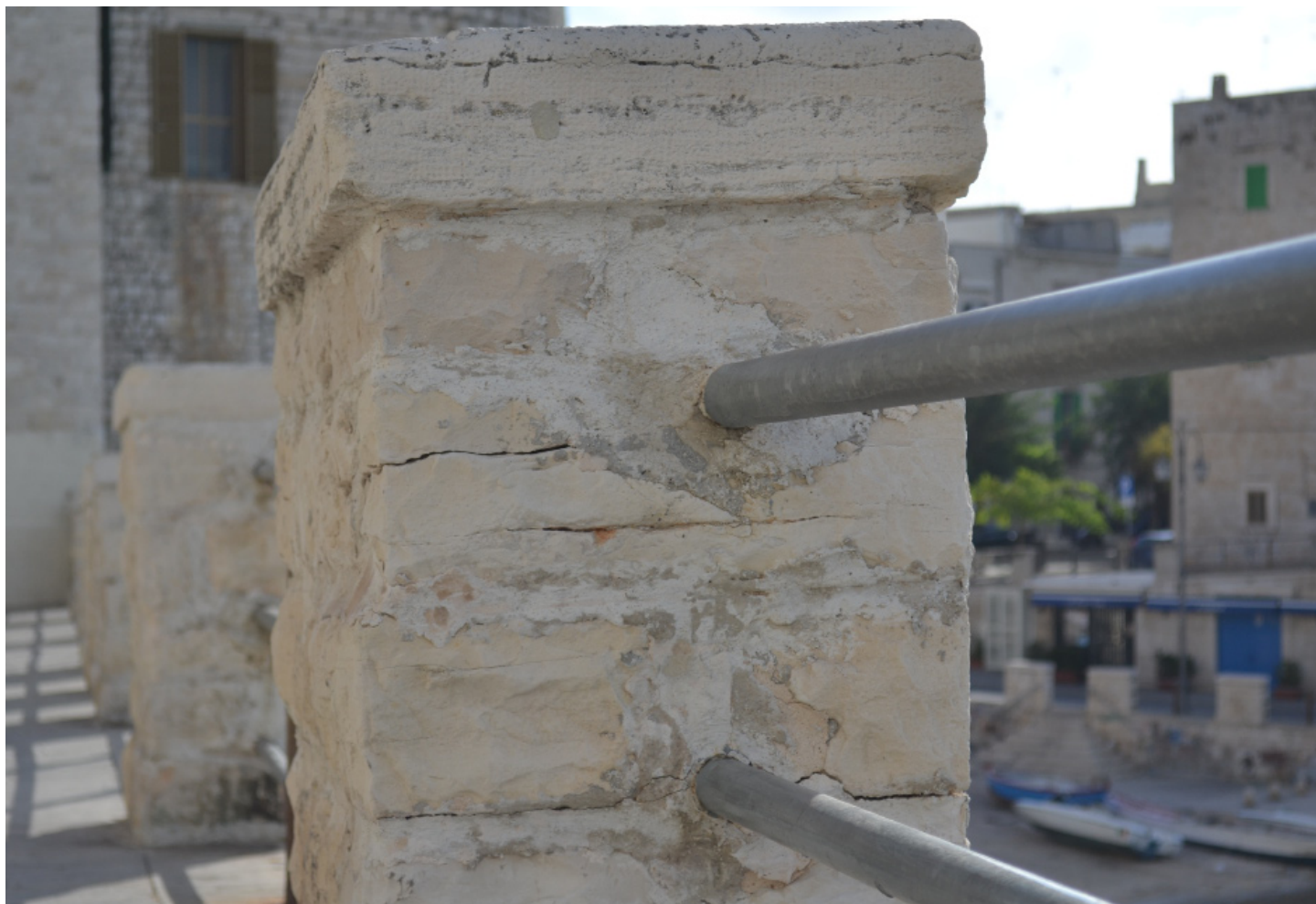
DEGRADO | particolare dell' attacco tra il parapetto in pietra e la balaustra in ferro
