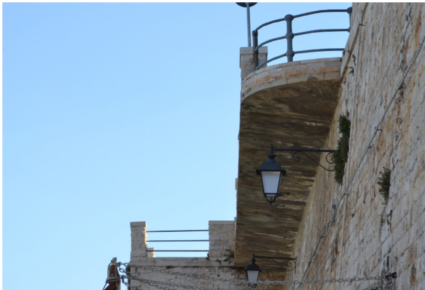
DEGRADO | intradosso della soletta aggettante in c.a.
