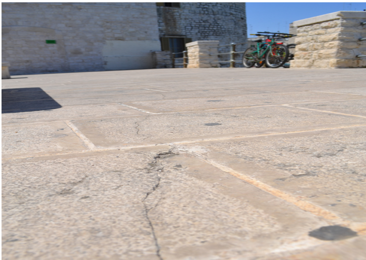
DEGRADO | particolare della pavimentazione in pietra lungo via Marina
