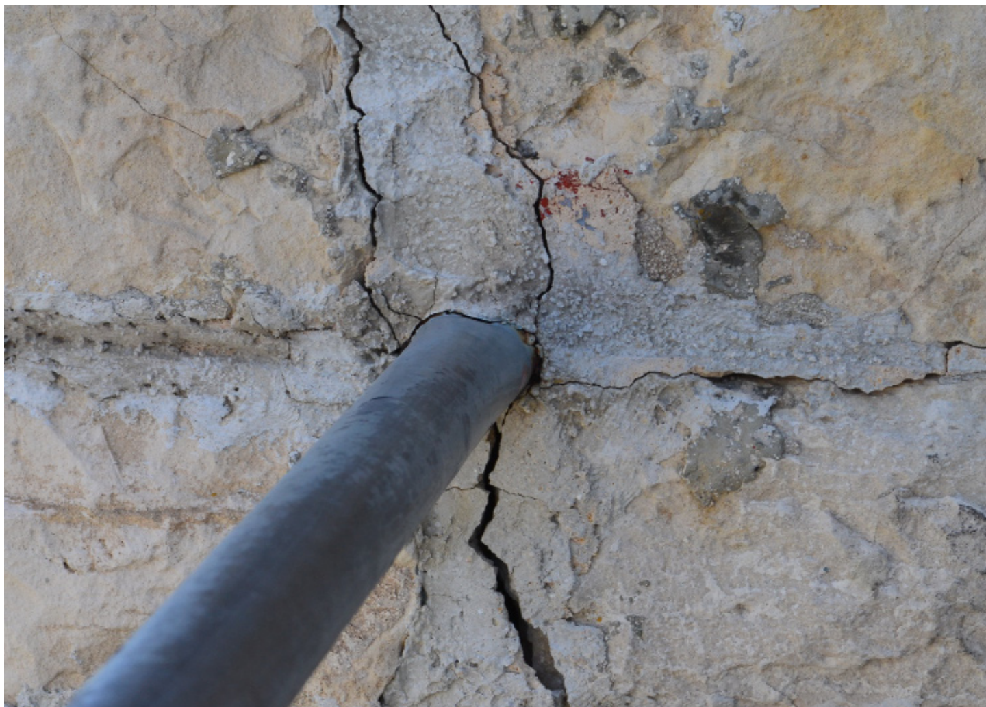
DEGRADO | particolare dell' attacco tra il parapetto in pietra e la balaustra in ferro
