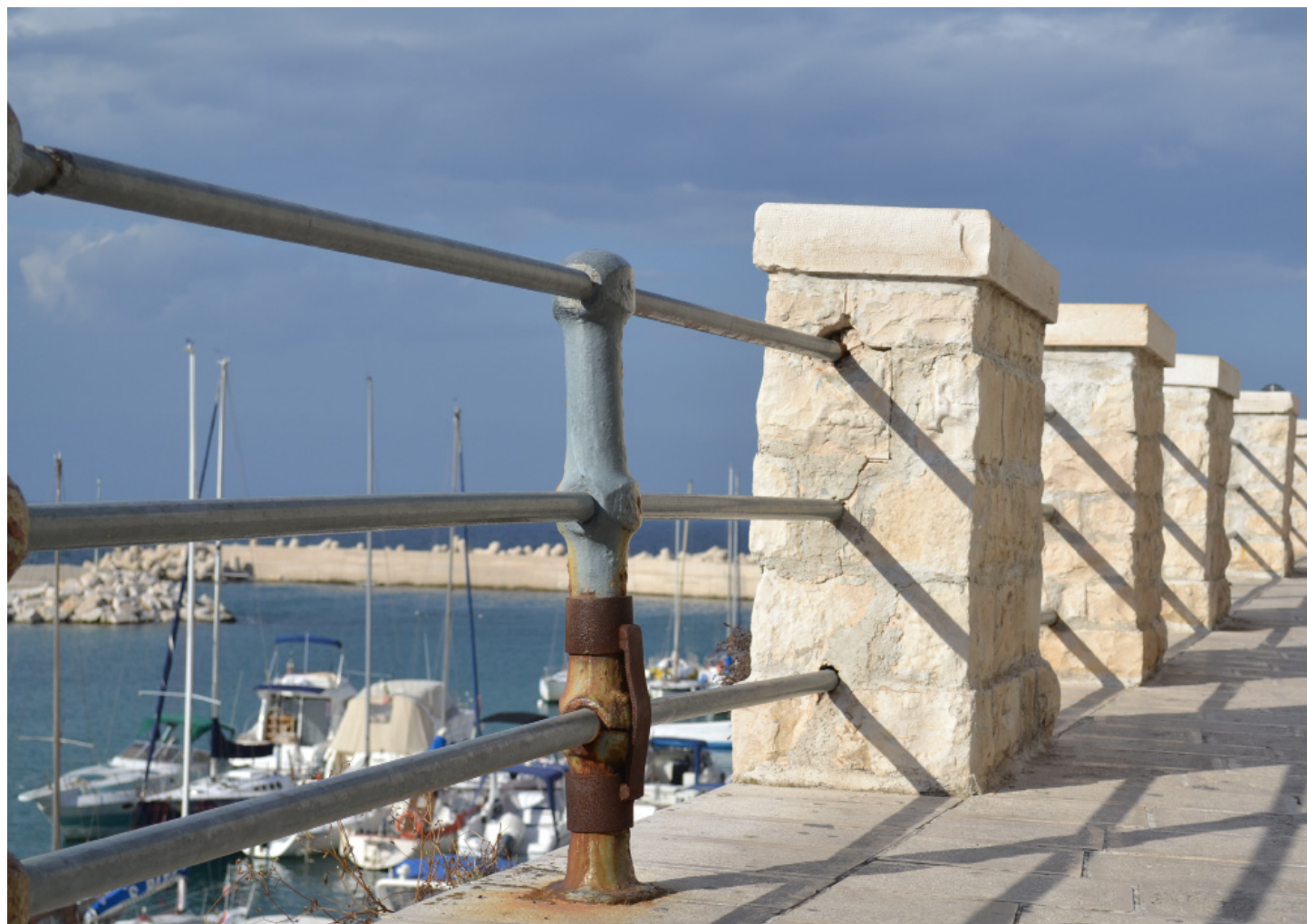
DEGRADO | particolare della balastra in ferro
