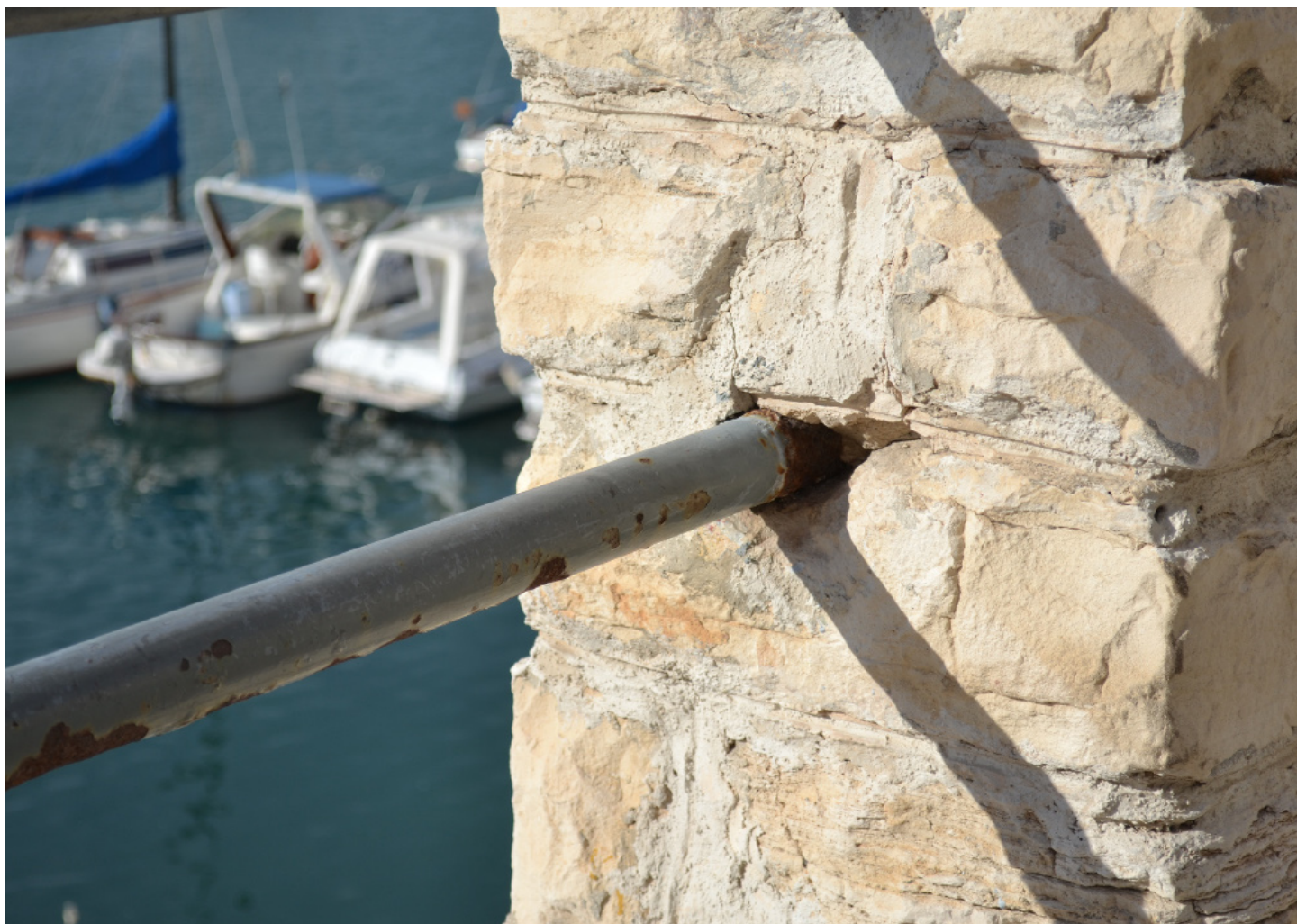
DEGRADO | particolare dell' ammorsamento tra il parapetto in pietra e l' asta in ferro della balaustra
