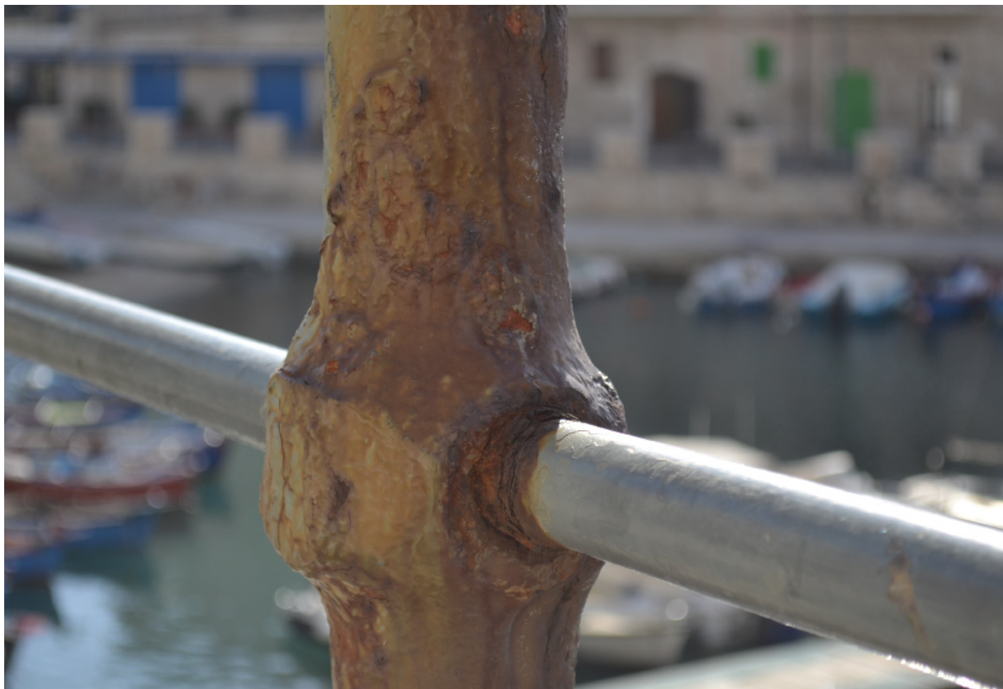
DEGRADO | particolare dell' attacco asta-bastone delle balaustre in ferro
