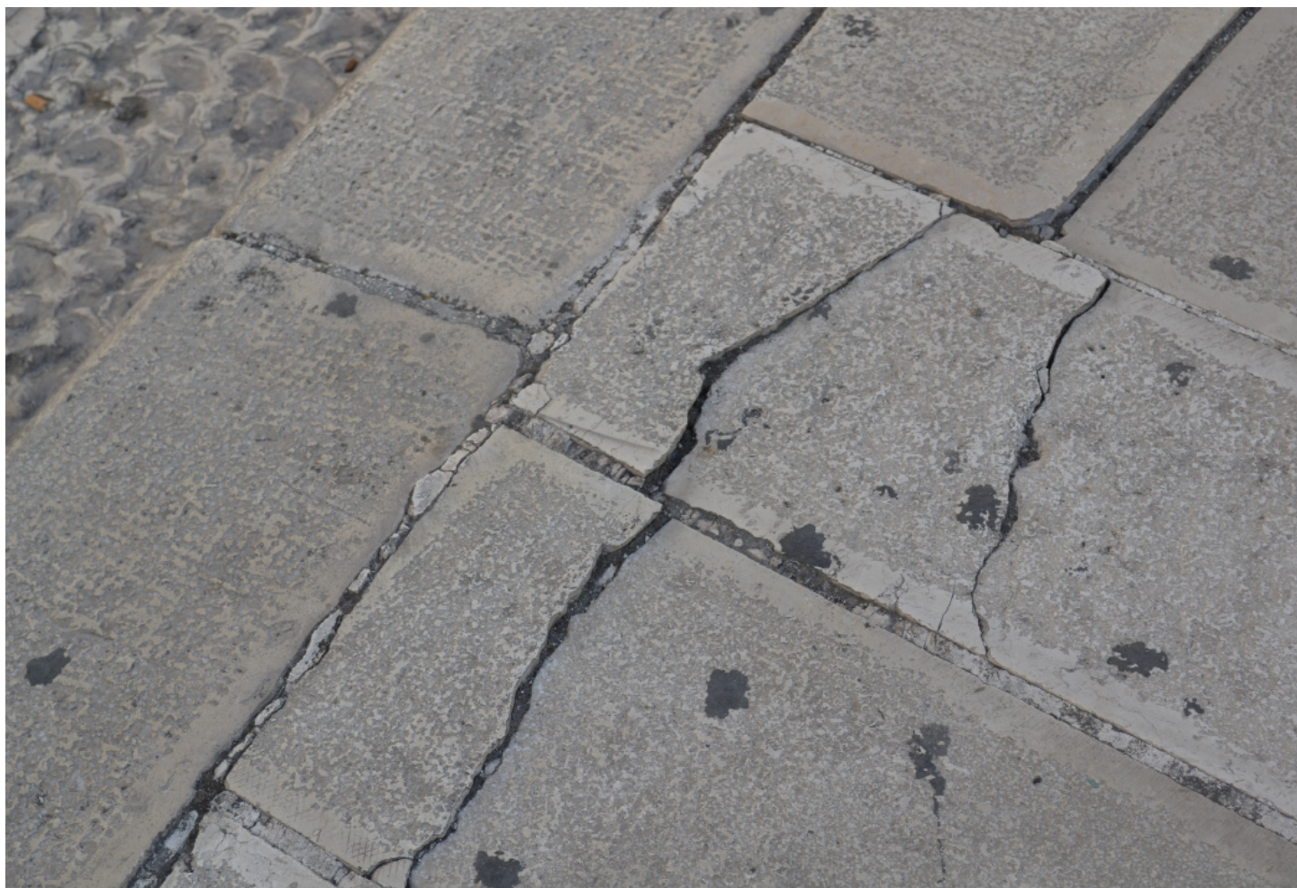
DEGRADO | particolare della pavimentazione in pietra lungo via Marina
