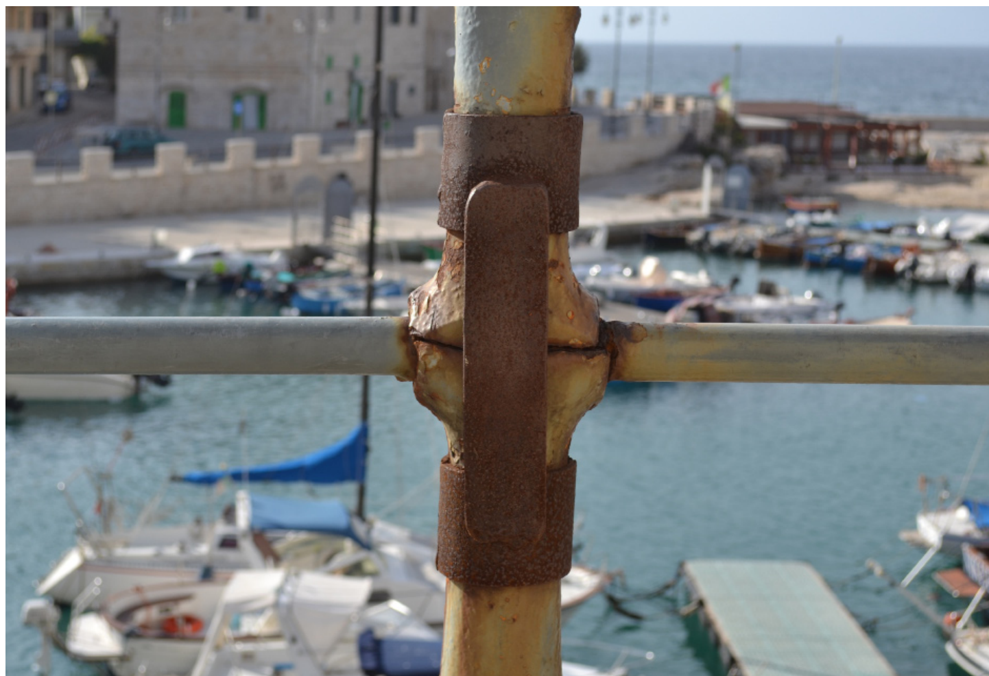
DEGRADO | particolare della balastra in ferro
