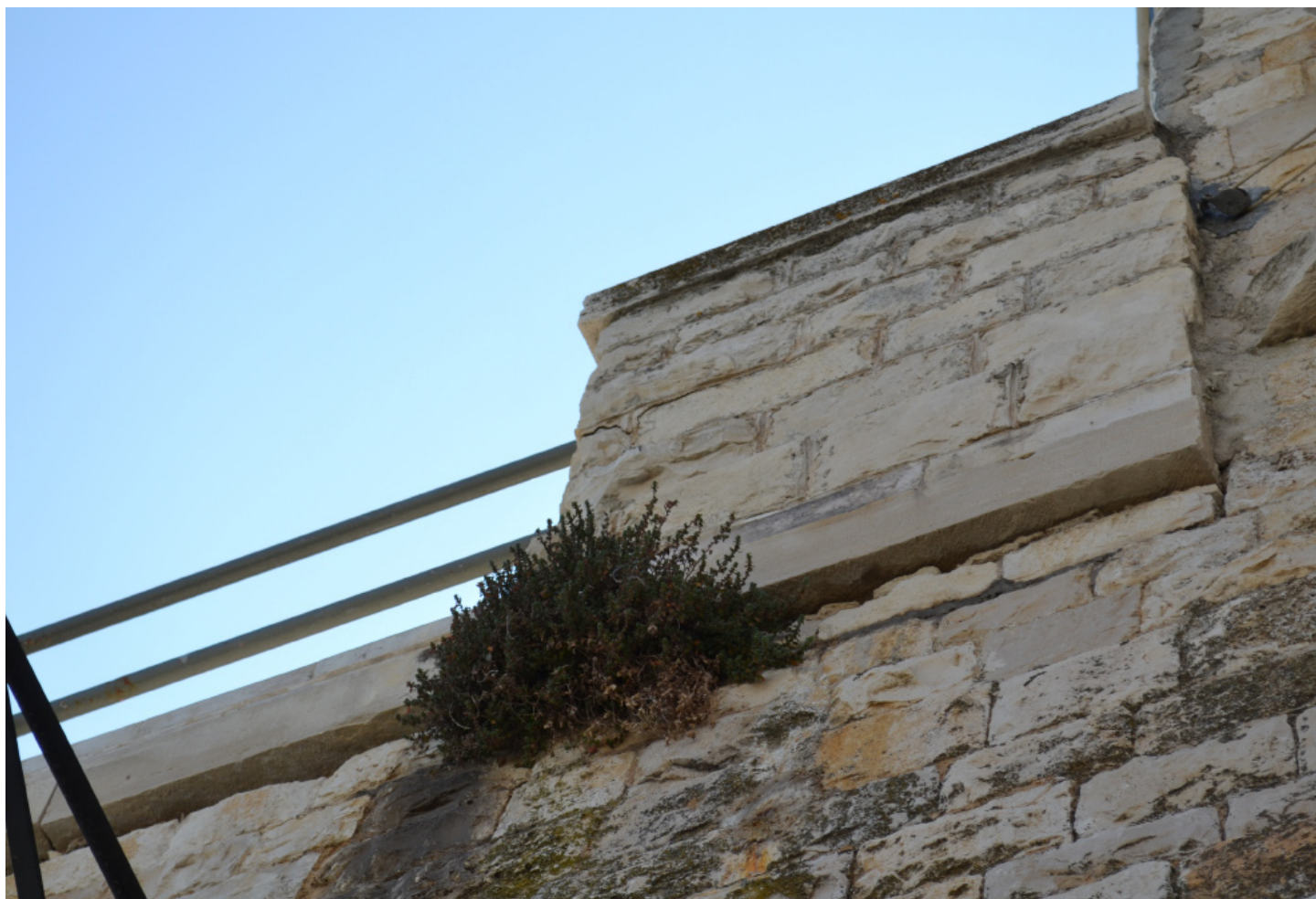
DEGRADO | particolare dell' attacco tra il muraglione e il parapetto in pietra
