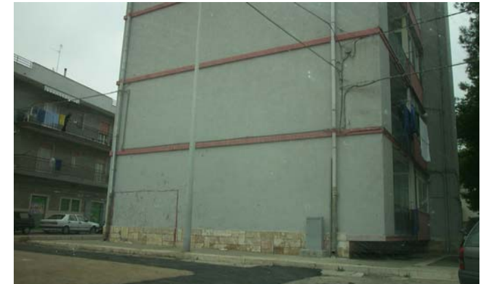
piazza SICOLO Impianto n°109
