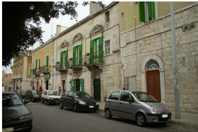
via CAPPUCINI Impianto n°96
