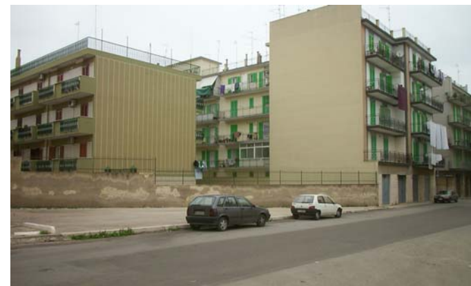
1° trav. XX SETTEMBRE Impianto n°69
