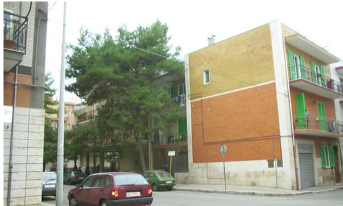
via DE GASPERI Impianto n°108
