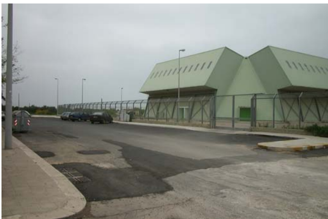
via Moro Impianti da n°47 a n°49 e n°51
