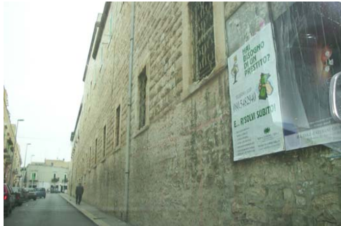
via MARCONI Impianto n°105
